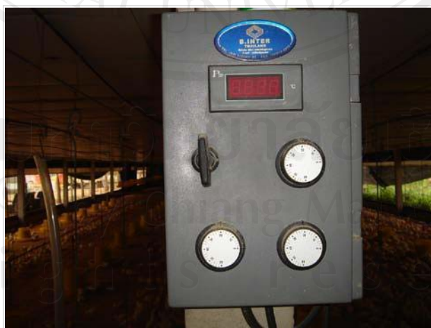
ภาพ 2.4 เครื่องควบคุมอุณหภูมิ หน้าจอแสดงอุณหภูมิภายในโรงเรือน ประกอบด้วยปุ่มปิด-เปิด พัดลมและปั้มน้ำ
