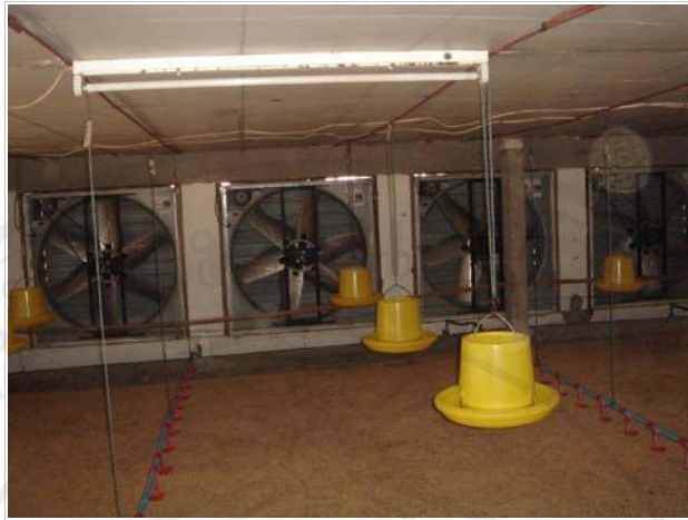
ภาพ 2.7 พัฒนาคูอากาศ ขนาดเส้นผ่าศูนย์กลาง 48 นิ้ว และการยกภาชนะให้อาหารไว้ก่อนการนำไก่เข้าโรงเรือน
