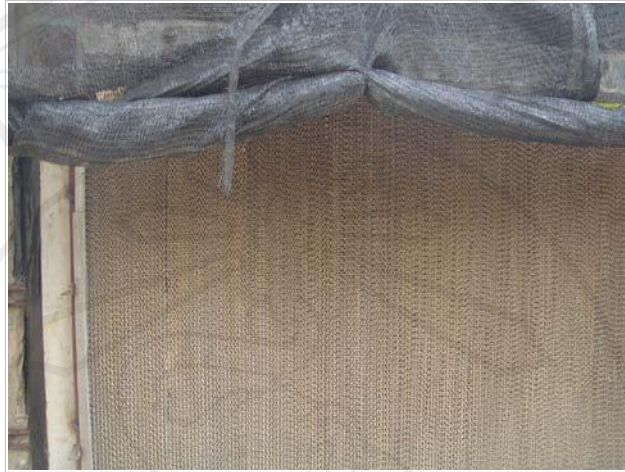
ภาพ 2.6 แผ่นรังผึ้ง (Cooling Pad) ที่มีขนาดเท่าฝาผนังของโรงเรือน
