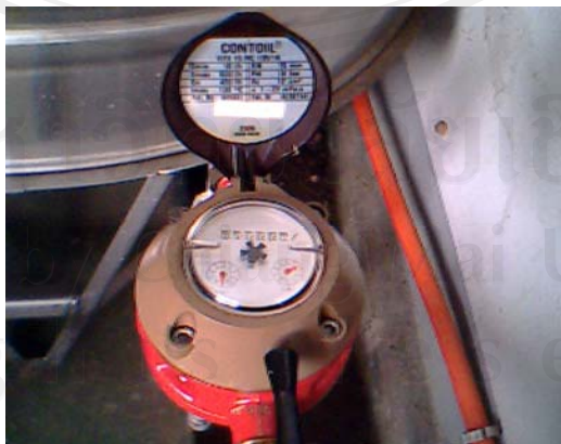
ภาพที่ ก5 มาตรวัดปริมาณการไหลของน้ำมัน โดยหน่วยวัดปริมาตรน้ำมันหน่วยเป็นลิตร
