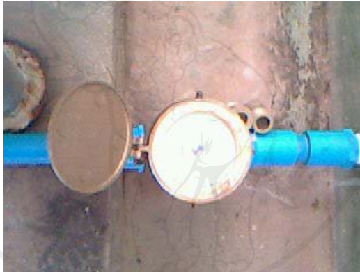
ภาพที่ ก4 มาตรวัดปริมาณการไหลของน้ำ โดยหน่วยวัดปริมาตรน้ำหน่วยเป็นลิตร
