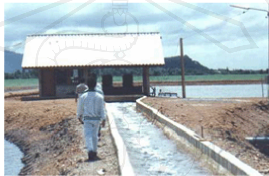
รูปที่ 9 โรงสูบน้ำและรางขนส่งน้ำแบบเปิด
