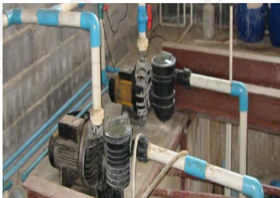
ภาพที่ 16 ภาพแสดงปั๊มที่ใช้ในระบบปลูกแบบ NFT
