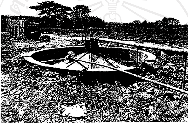
รูปที่ 2-9 แสดงลักษณะบ่อหมักเร็วแบบ UASB ของประเวศฟาร์ม
