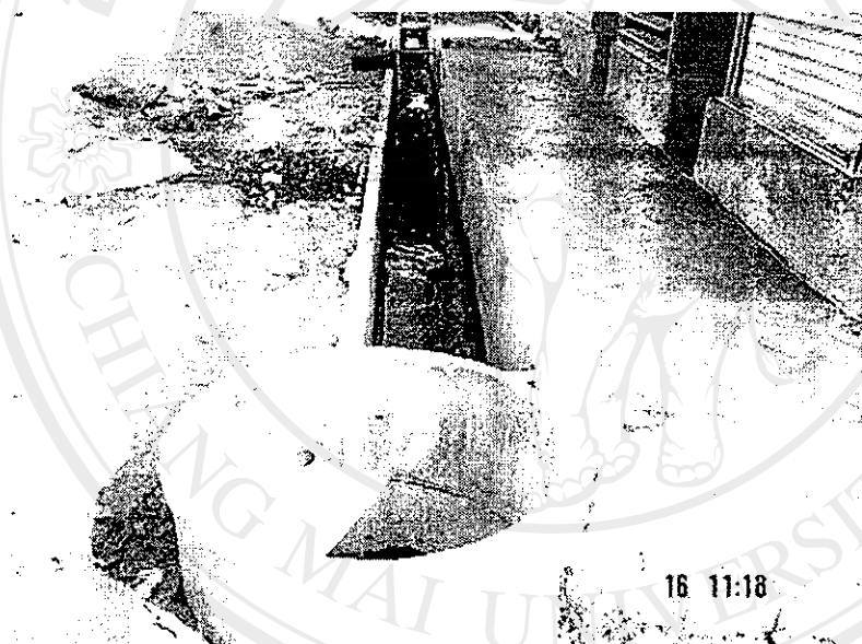
รูปที่ 2-5 แสดงลักษณะระบบส่งลำเลียงน้ำเสียของประเวศฟาร์ม
