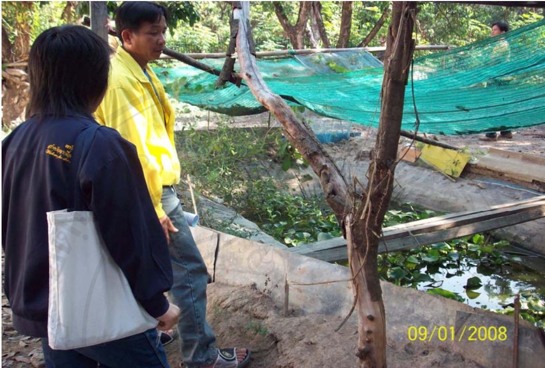
ภาพที่ 3 บ่อที่มีการทำหลังคาเพื่อป้องกันเศษใบไม้ร่วง
