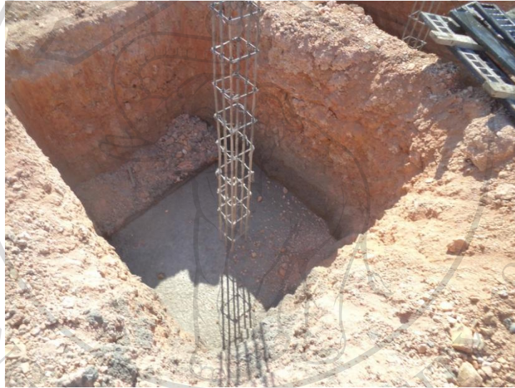
รูป 3.6 การสร้างฐานรากแบบตื้นหรือแบบแผ่ที่มา : (www.chiangraifocus.com, 2012)
