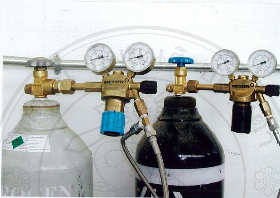
รูปที่ 3 ถังก๊าซ ความดัน 1500 bar
