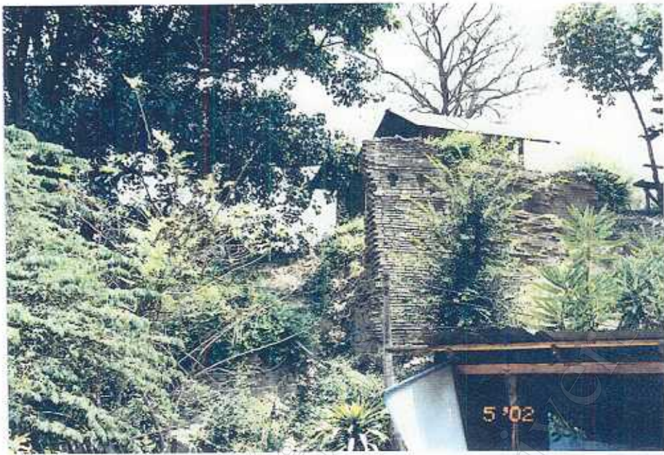
ภาพที่ 9 บริเวณป้อมกกลม(ป้อมหยาชยา) ที่มีการก่อสร้างกำแพงก่ออิฐด้านนอกฝั่งด้านใต้ และยังคงมีความสมบูรณ์ในรูปแบบศิลปกรรมอยู่
