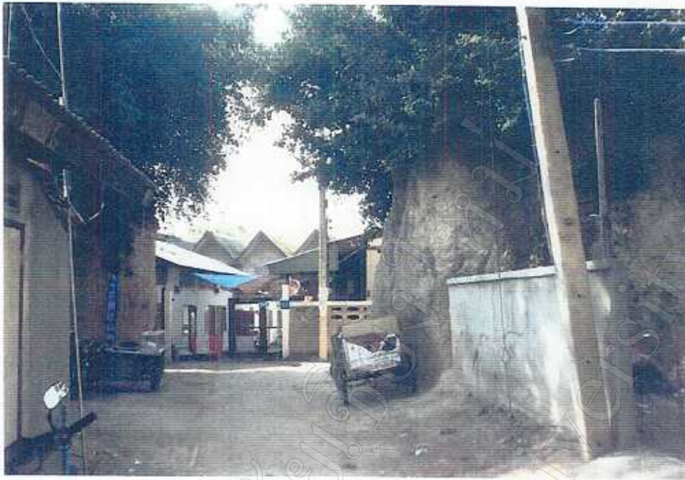
ภาพที่ 6 แสดงการขุดเจาะแนวกำแพงเพื่อเป็นทางเดินเชื่อมต่อภายในชุมชนที่พยเนตร โดยชาวบ้านผู้บุกรุกและเทศบาลนครเชียงใหม่ได้สร้างทางเดินเสริมให้เพื่อช่วยเหลือชุมชนอีกทางหนึ่ง
