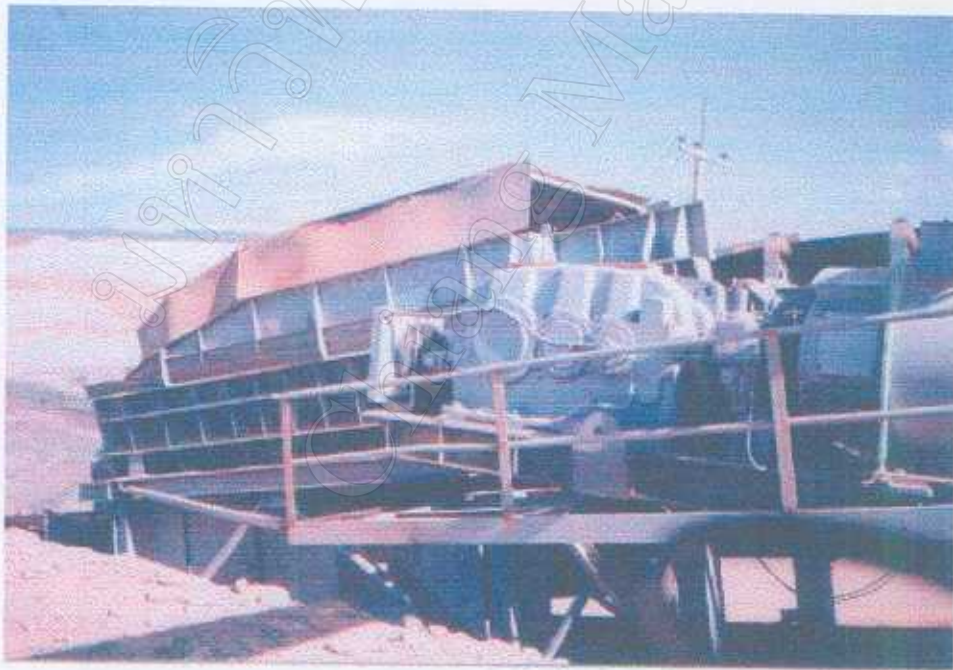
ภาพแสดงการติดตั้งฝากรอบป้องกันการฟุ้งกระจายของฝุ่นละออง ที่บริเวณ Box Chute และ I.U.Drive
