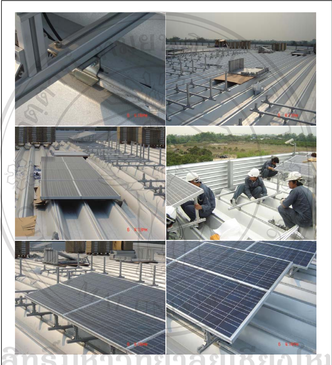
ภาพที่ 12 ขั้นตอนการติดตั้งฐานรองและแผงโซลาร์เซลล์
