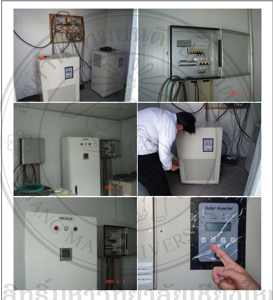
ภาพที่ 16 ขั้นตอนการติดตั้งเครื่องแปลงกระแสไฟฟ้าและตู้ควบคุมระบบไฟฟ้า
