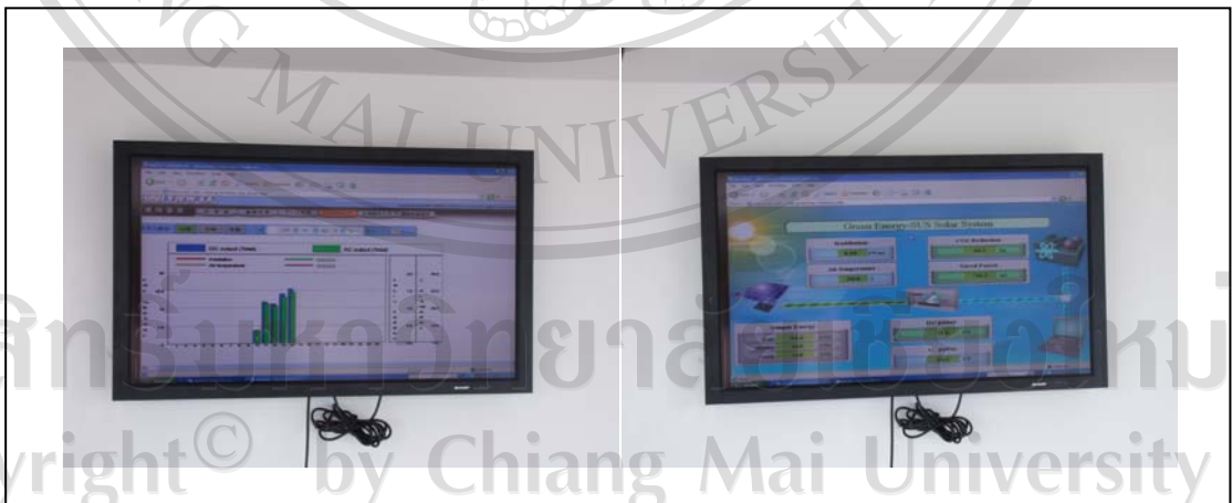
ภาพที่ 18 ขั้นตอนการติดตั้งจอมอนิเตอร์
