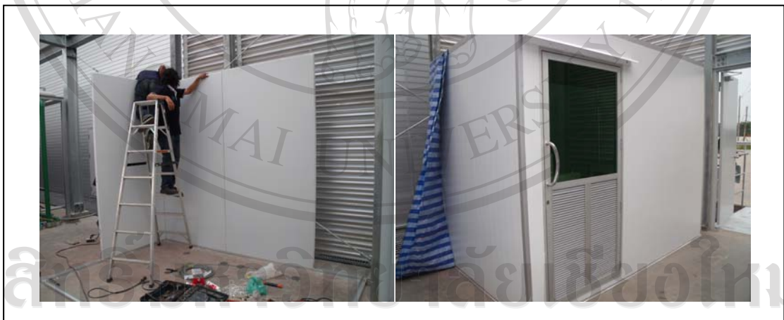
ภาพที่ 15 ขั้นตอนการก่อสร้างห้องควบคุมระบบ
