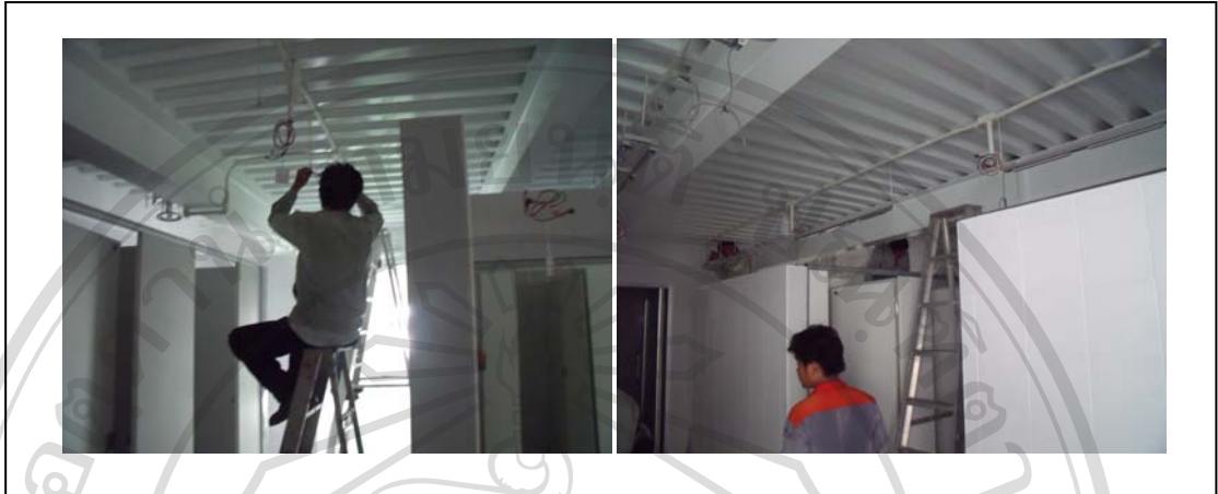
ภาพที่ 17 ขั้นตอนการเดินสายภายในอาคาร
