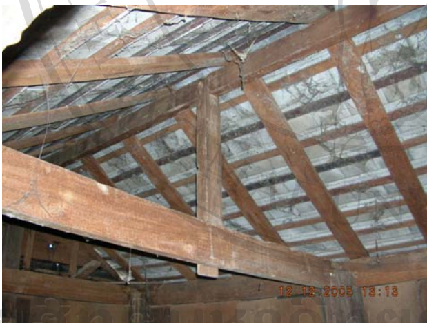
ภาพ 62 ซื่อ อะเส ตั้งไม้ ออกไก่ จันทัน ระแนง
