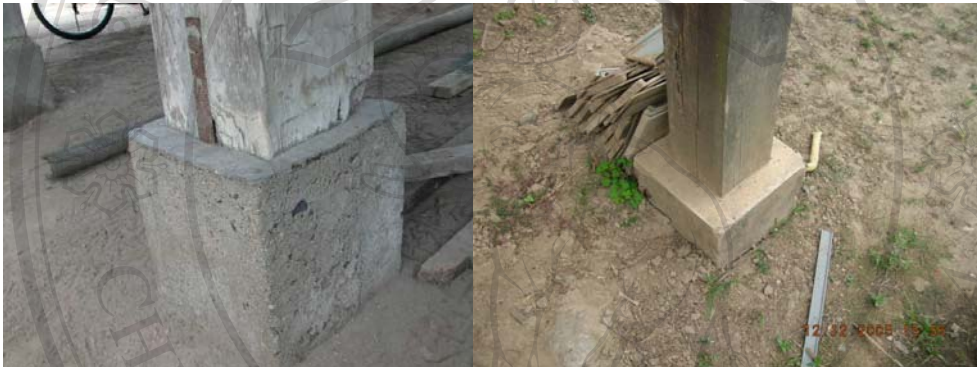
ค. ฐานเสาต่อม่อคอนกรีต
