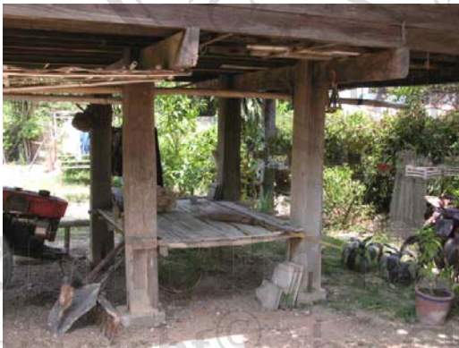
ภาพ 53 เสาหลองข้าวที่เป็นเสาไม้จริง
