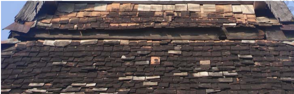
ภาพ 64 กระเบื้องดินขอ (ดินเผา)
