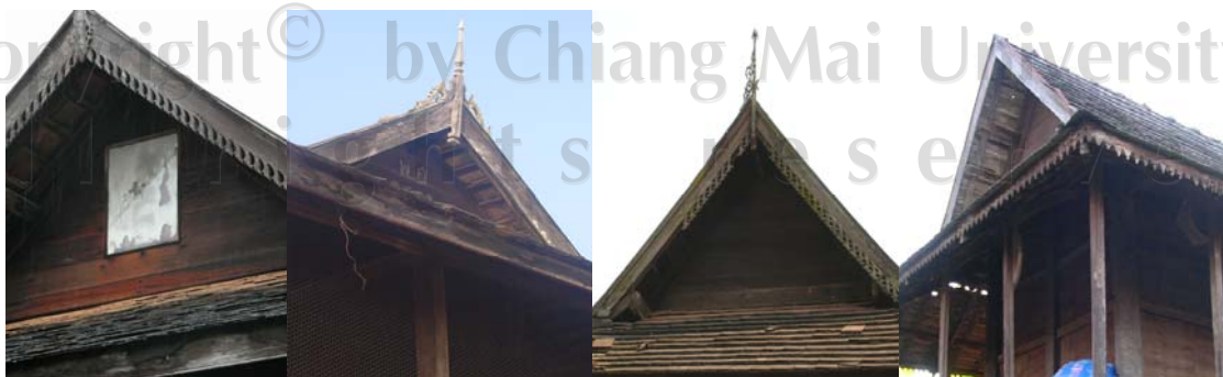
ภาพ 63 น้ำย่อย (เชิงชาย) ปั้นลม ไม้หน้าแหบ (หน้าจั่ว)
