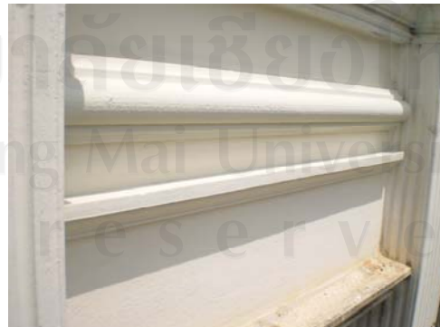
ภาพ 5.19 บัวที่ติดตั้งกับผนัง ทาสีแล้วเสร็จ
