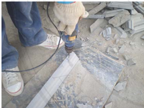
ภาพ 5.16 แสดงการเจาะรูเพื่อฝากเหล็ก
