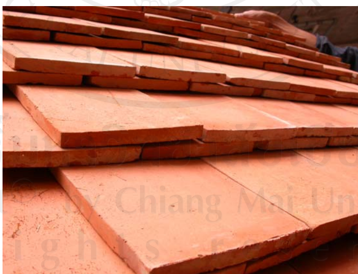
ภาพที่ 4.12 กระเบื้องมีการบิดงอ เกิดช่องว่างหลายแห่ง
