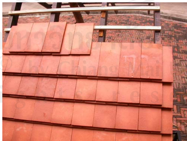
ภาพที่ 4.10 รอยหยดน้ำที่ค้างอยู่หลายจุดตามแผ่นกระเบื้อง
