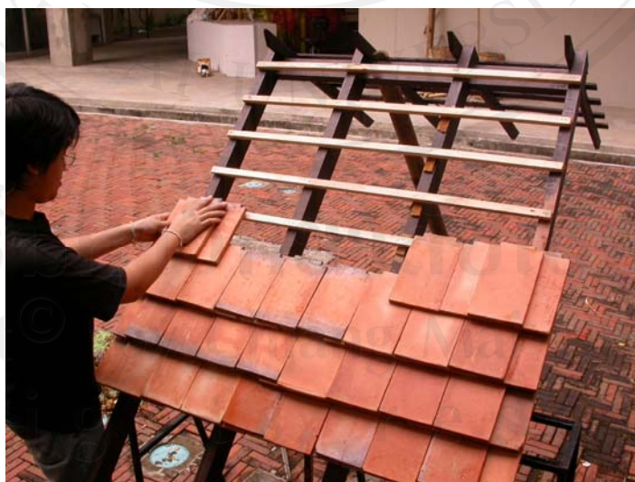
ภาพที่ 4.16 ลวดลายหลังการมุงไม่เป็นระเบียบเนื่องจากการบิดงอ
