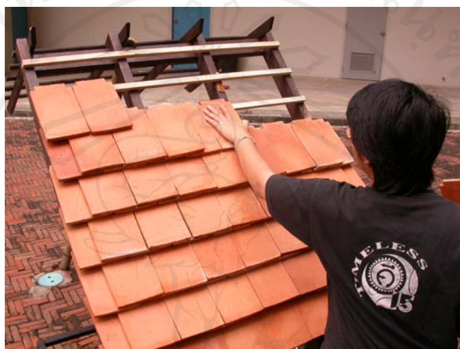
ภาพที่ 4.11 การมุงหลังคากระเบื้องมุงหลังคาดินขอ ชนิด จศ.
