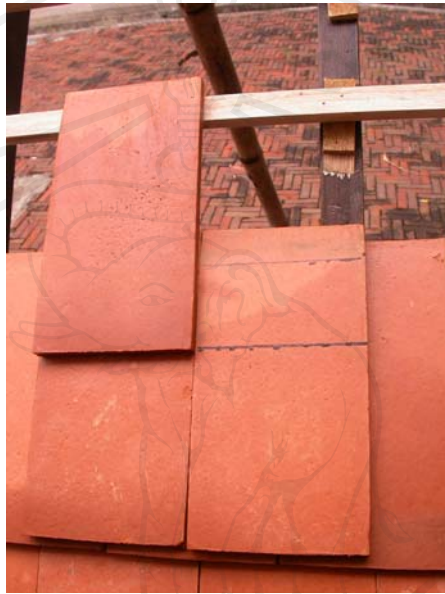
ภาพที่ 4.9 แสดงรอยน้ำที่เกิดขึ้นใต้แผ่นกระเบื้องจากแรงตึงผิว
