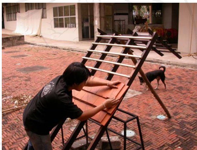
ภาพที่ 4.7 การมุงหลังคากระเบื้องมุงหลังคาดินของชนิดเรียบ 2 ด้าน
