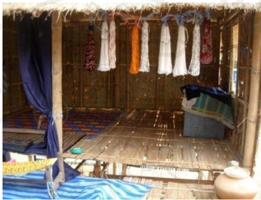
ภาพที่ 5.1 พื้นสับฟากจากเรือนพักนอนของชาวบ้าน
