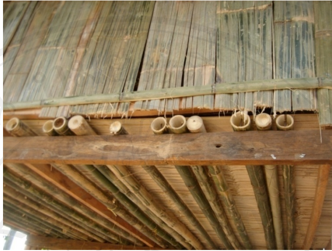
ภาพที่ 5.10 รูปภาพการใช้ไม้ไผ่สับฟากในการทำพื้นและฝาผนัง
