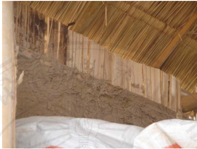
ภาพที่ 5.3 ผนังสับฟากโบกด้วยดิน
