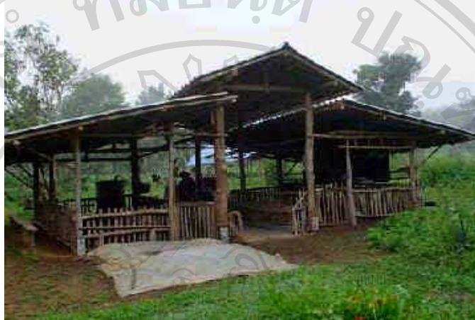
ภาพ 3 โรงเรือนแบบหลังคาซ้อน (ชูชีพ, 2549)
