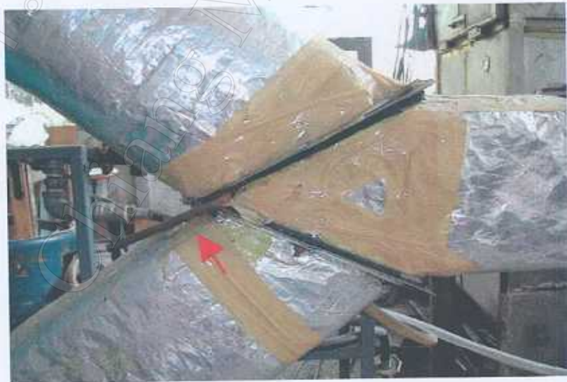
รูปที่ 3.5 คันบังคับลิ่มปรับเปลี่ยนทิศทางการไหลของลมร้อน (ลูกศรชี้)
