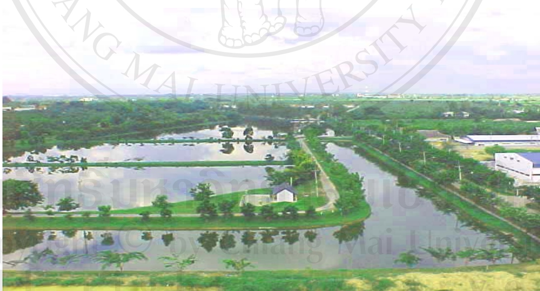
ภาพที่ 4 บ่อบำบัดน้ำเสียส่วนกลางในนิคมอุตสาหกรรมภาคเหนือ
