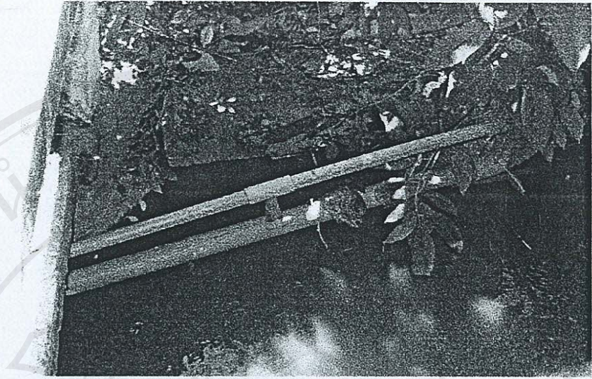
ภาพแสดงการติดตั้งประตูน้ำในท่อก๊าซชีวภาพ สำหรับระบายน้ำที่ขังอยู่ในท่อออก
