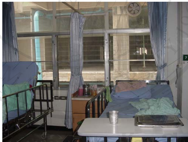
รูปที่ 7 บริเวณด้านข้างหอผู้ป่วยที่มีการก่อสร้าง
