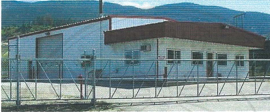
ภาพจำลองคลังเก็บสินค้า (อยู่ในระหว่างการก่อสร้าง)
