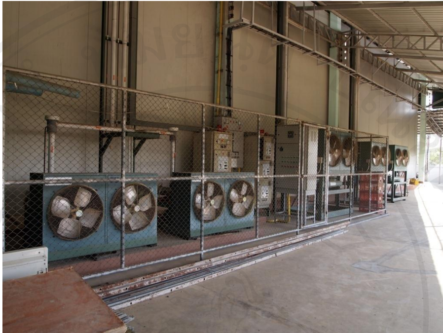
ภาพที่ ก-5 คอมเพรสเซอร์ของโรงงานห้องเย็น
