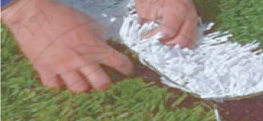
ภาพที่ 19 การปูหญ้าเทียมที่มีสีขาวแทนการตีเส้น (Nicho Company Limited, 2547: Online)
