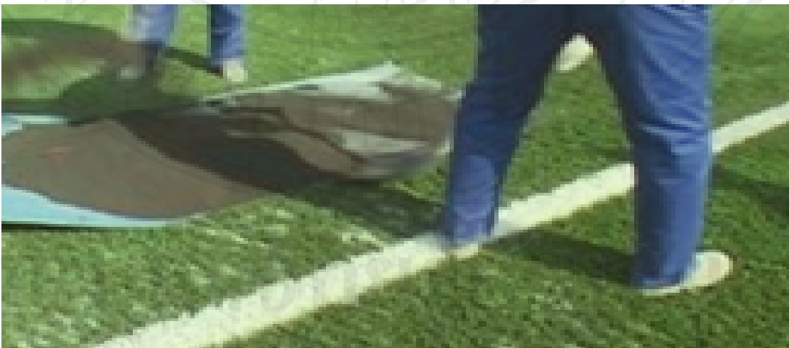
ภาพที่ 20 การเททรายลงบนผืนหญ้าเทียม (Nicho Company Limited, 2547: Online)
